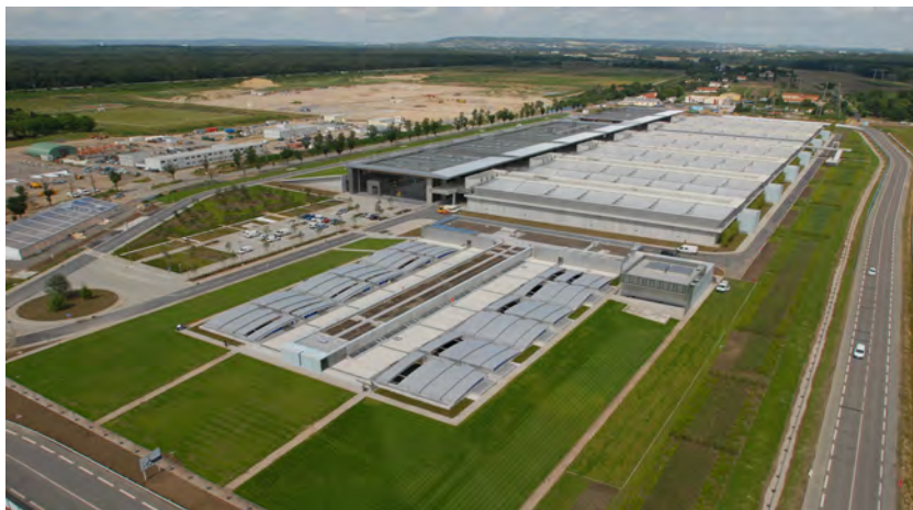
Photo 9. Vue aérienne de l'unité de traitement de l'azote par biofiltration intégrée dans la file de traitement des eaux de la station d'Achères (Seine Aval)
