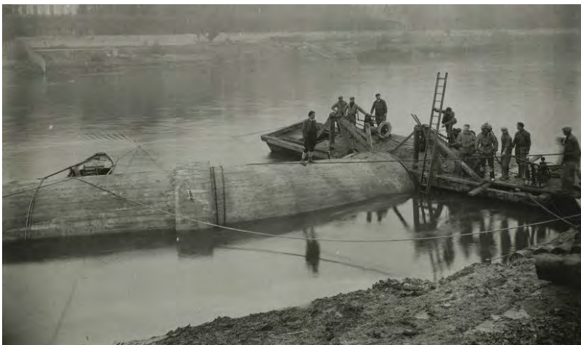
Photo 5. Construction de l'émissaire Sèvres-Achères (1954) pour alimenter la station d'épuration d'Achères
